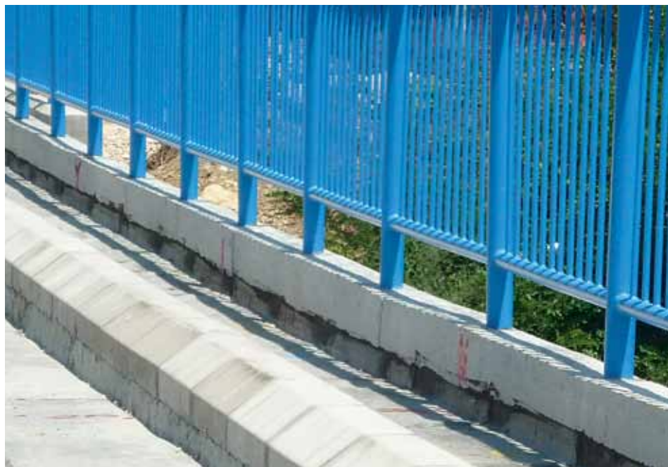
Слика 11. Изградња новог моста (Њ. Драговић, 2011)
