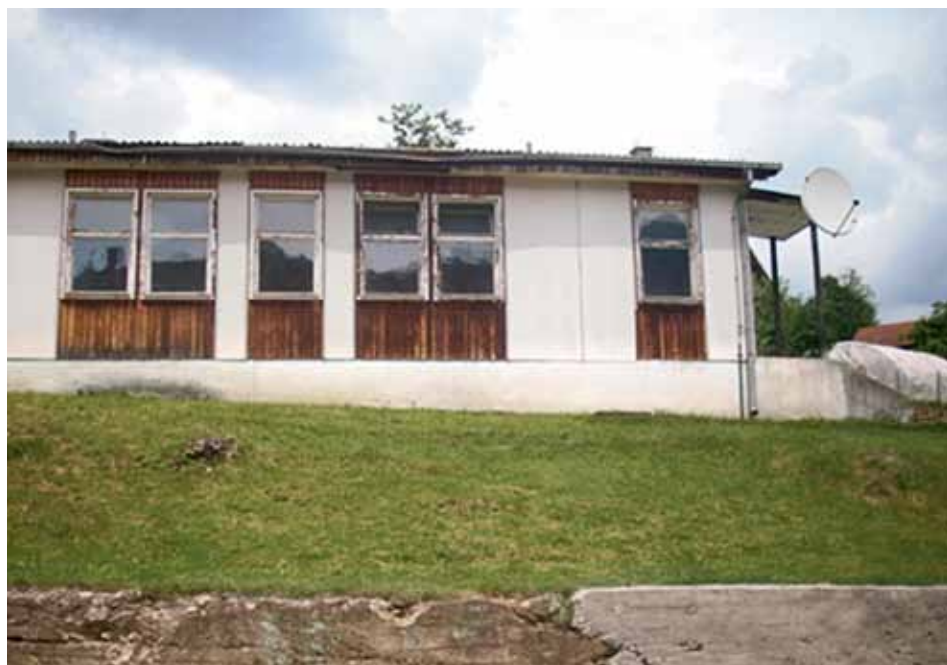
Слика 8. Зграда некадашње школске кухиње (Д. Здравковић, 2011)
