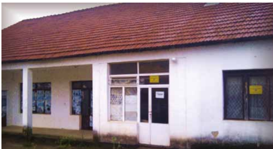
Слика 5. Просторије угашене задруге
