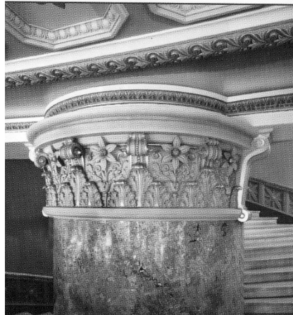
Detaliu al coloanei de susținere a unei scări încolăcite și a balconului ei (pg. 15 - Nicolae St.Noica - ATENEUL ROMÂN ȘI CONSTRUCTORII SĂI)
