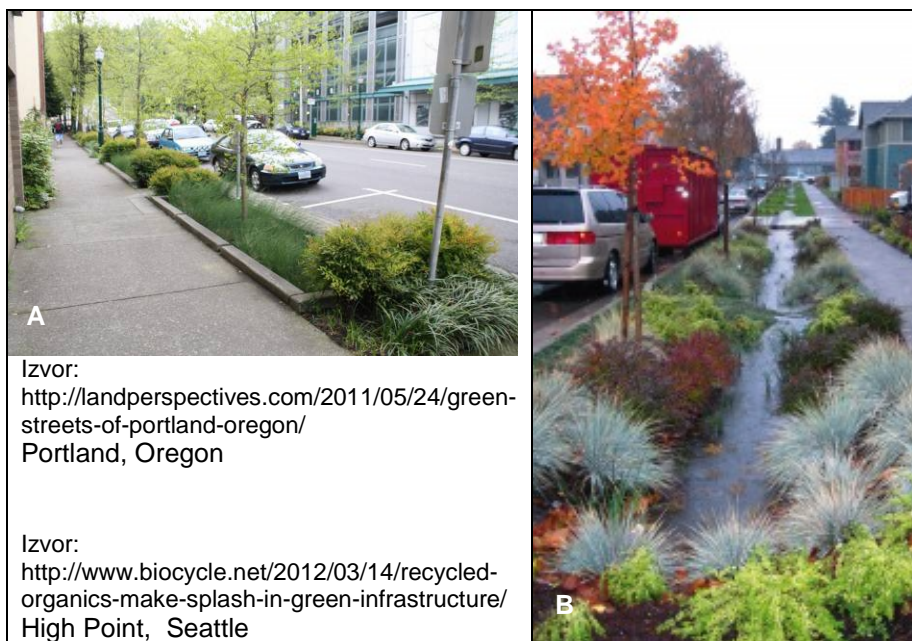
Slika 3. Infiltracioni kanal i ozelenjena depresija sa vodom u funkciji povećanja stepena bezbednosti pešačkog kretanja u sklopu ulica.
